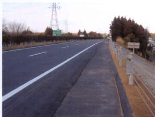
平成23年3月17日 復旧完了
